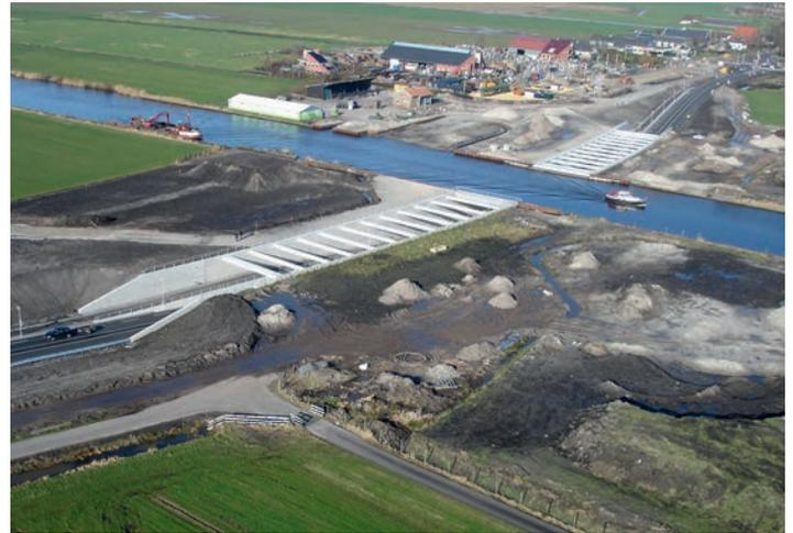
Figura 8. Vista aérea del proyecto Lagos de Frisia: la nueva carretera pasa por debajo de la vía fluvial, lo que facilita el tráfico terrestre
