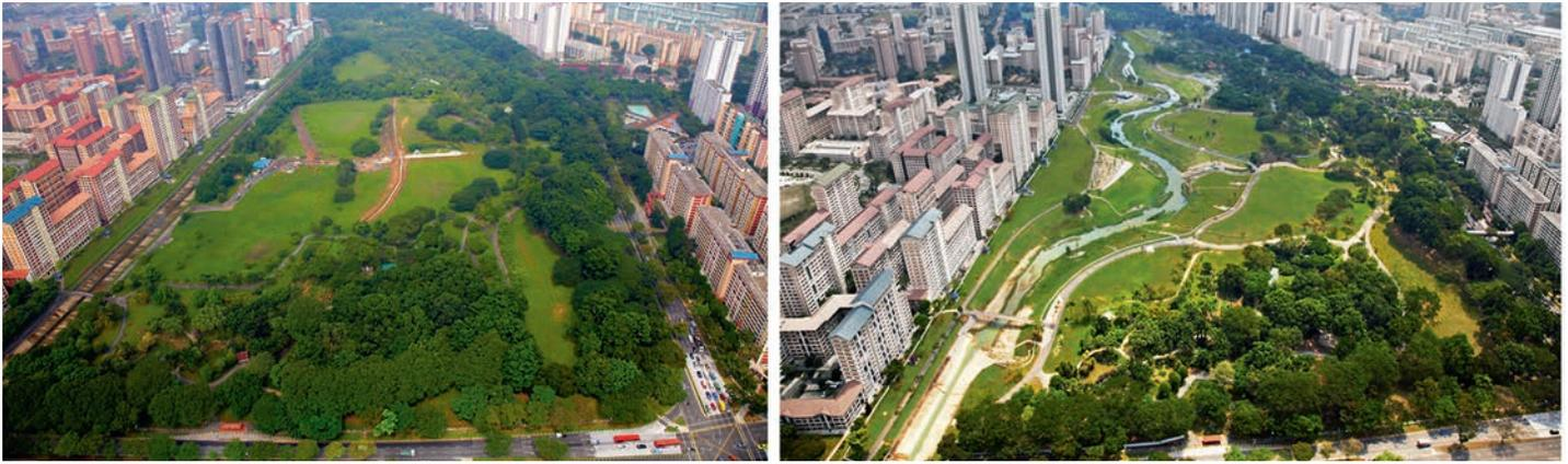
Figura 26. Río Kallang de Singapur antes (a la izquierda) y después (a la derecha) de que se aplicó Aguapuntura: el anterior canal de concreto se transformó en un río serpenteante, bordeado por parques verdes a cada lado.
